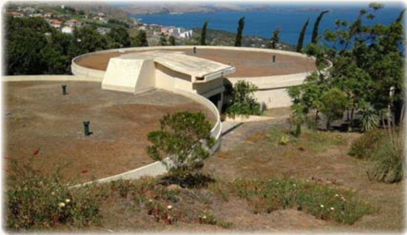
Reservatório da Bemposta (Machico) Volume - 4.000 m 3
