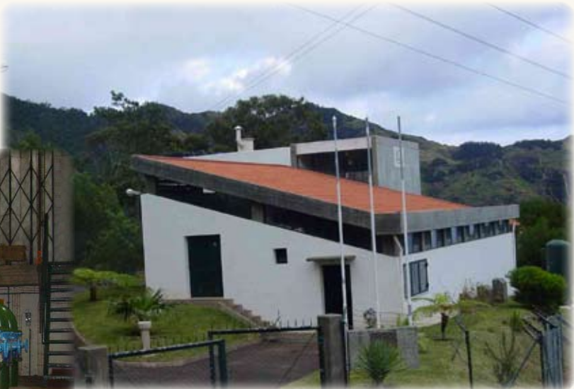
Estação de Cloragem e Elevatória da Zona Leste (Machico)
