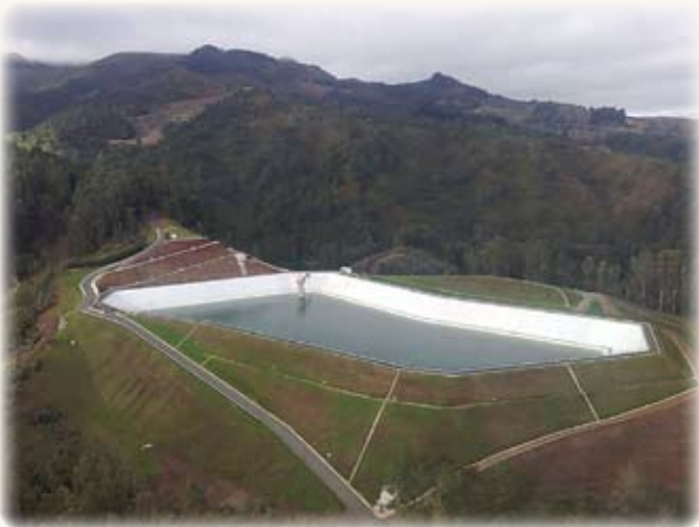
Lagoa das Águas Mansas
