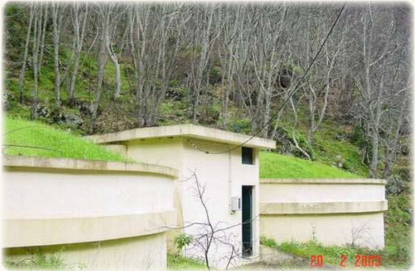
Estação de Tratamento de Água da Serra de Água Capacidade de tratamento - 1.382 m³/dia
