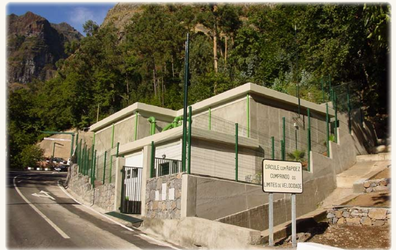
Estação de Cloragem do Curral das Freiras
