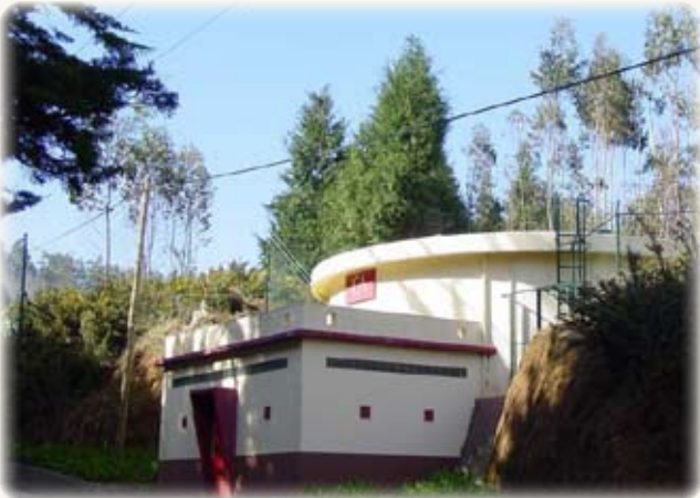
Reservatório R1 do Santo da Serra Volume - 1.200 m 3
