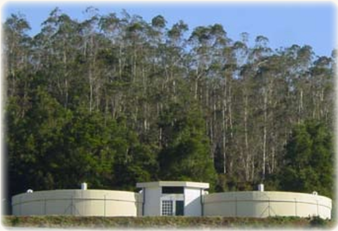
Reservatório R5 do Santo da Serra Volume - 1.000 m 3
