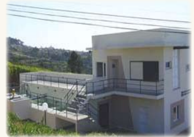
ETA da Fajã da Ovelha Capacidade de tratamento - 1.728 m 3 /dia
