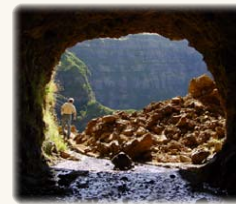
Galeria das Rabaças Comprimento - 1.500 m Caudal de exploração - 8.640 m 3 /dia
