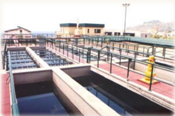
Estação de Tratamento de Água de Santa Quitéria São Martinho, Funchal
