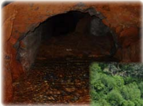
Galeria do Porto Novo (Santa Cruz) Comprimento: 2.230 m Caudal de exploração: 8.640 m 3 /dia
