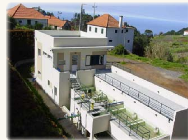
ETA dos Prazeres Capacidade de tratamento - 1.728 m 3 /dia
