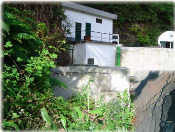
Reservatório das Fontes Vermelhas (Machico)
