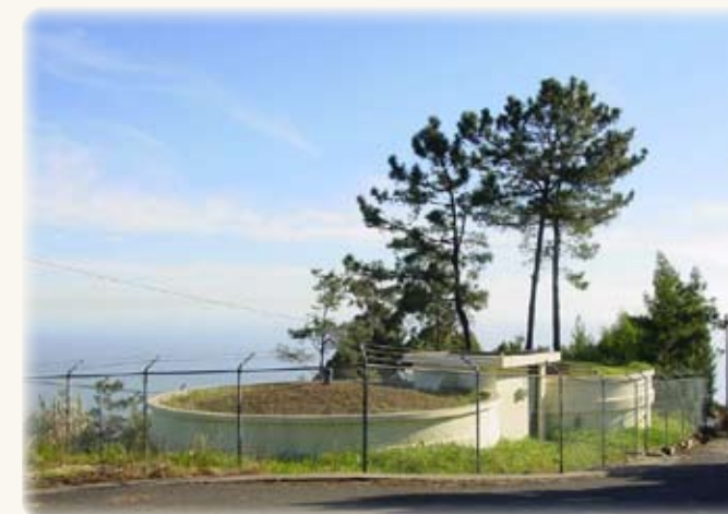
Reservatório da Apresentação Volume - 500 m 3
