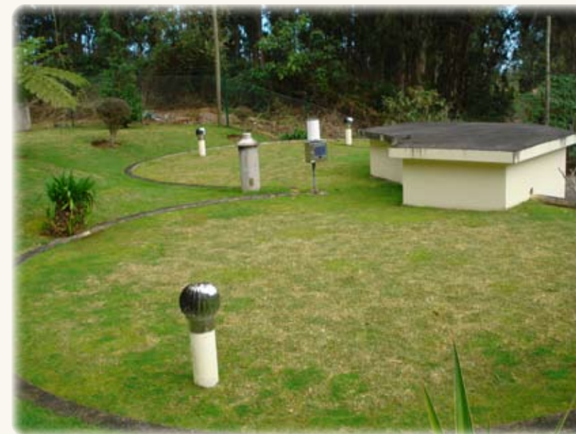
Reservatório da Estação de Tratamento de Água de São Jorge Volume - 210 m 3
