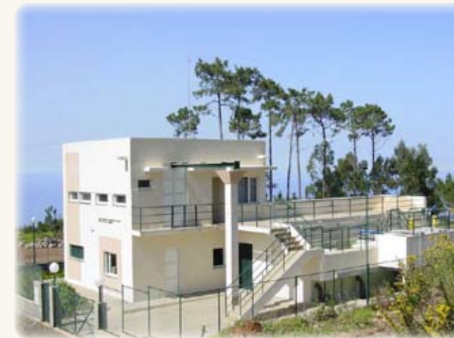
ETA da Ponta do Pargo Capacidade de tratamento - 1.728 m 3 /dia
