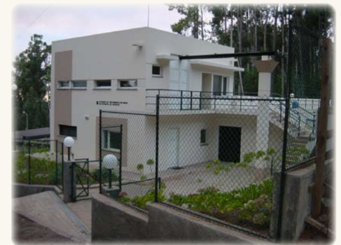
ETA do Estreito da Calheta Capacidade de tratamento - 1.728 m 3 /dia
